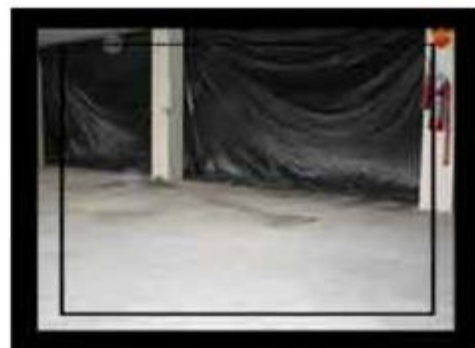
Retirada do carpete/ nivelamento do contrapiso
