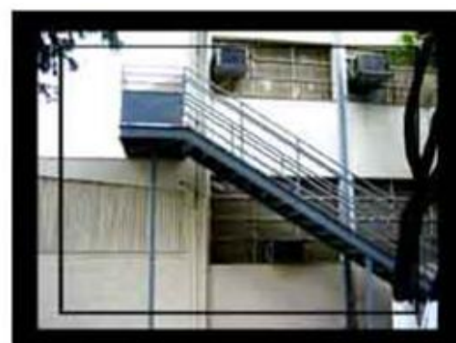
Fornecimento e Instalação de escada de emergência/ Implantação de ar condicionado
