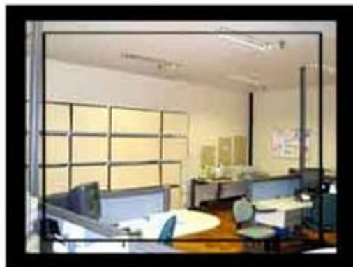
Reconstrução da alvenaria e nova pintura
