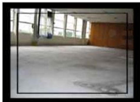
Nivelamento do contrapiso
